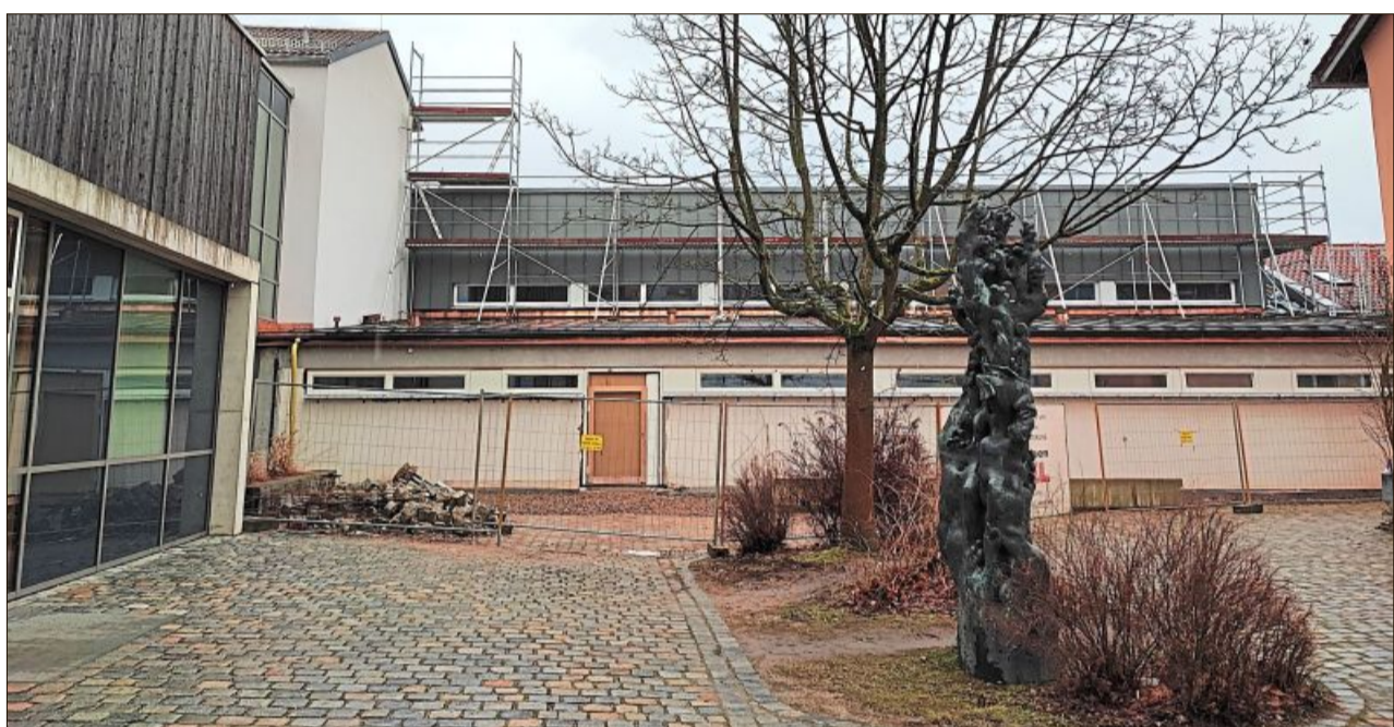
Direkt an die Further Realschule, die in den vergangenen Jahren aufwendig saniert wurde (links), grenzt die Turnhalle an.
