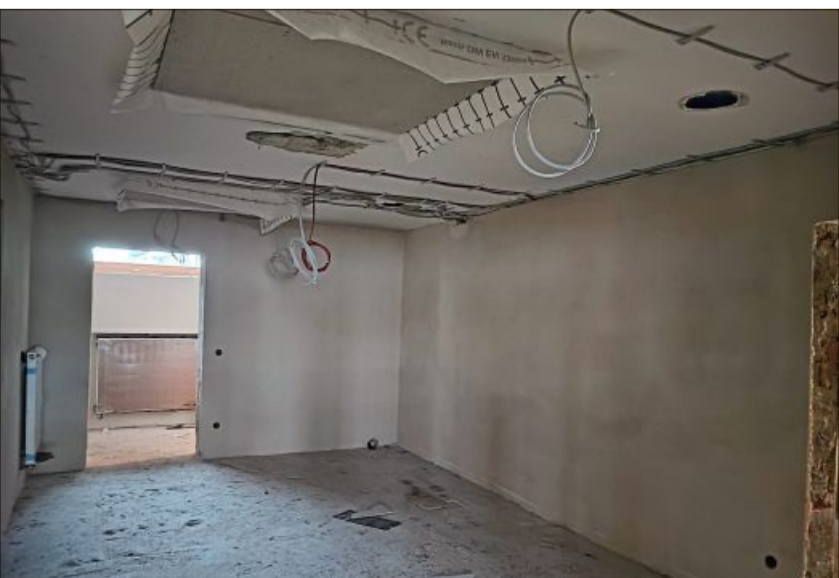
Räume wie die Umkleide oder die Toilette befinden sich noch im Rohbau.
