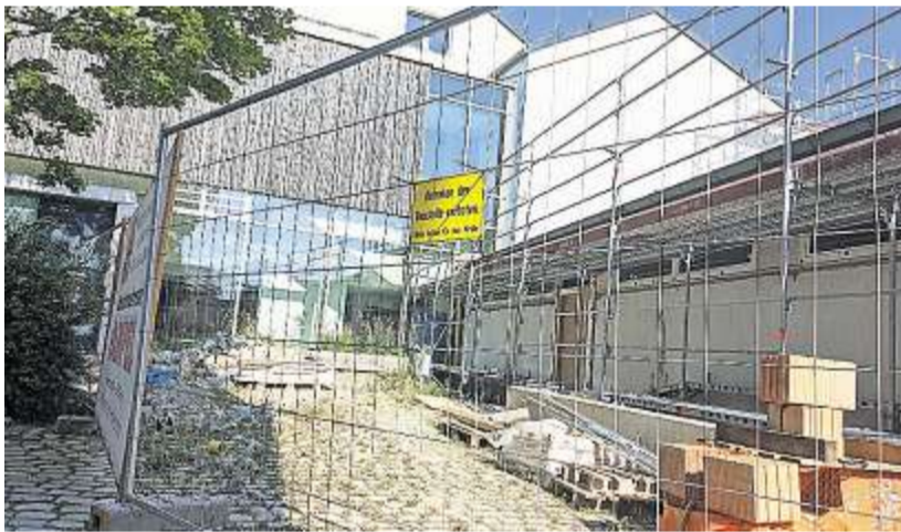
Unvollendet: Ein schönes Stück Baustelle haben ihre beiden Vorgänger der neuen Schulleiterin noch hinterlassen.
