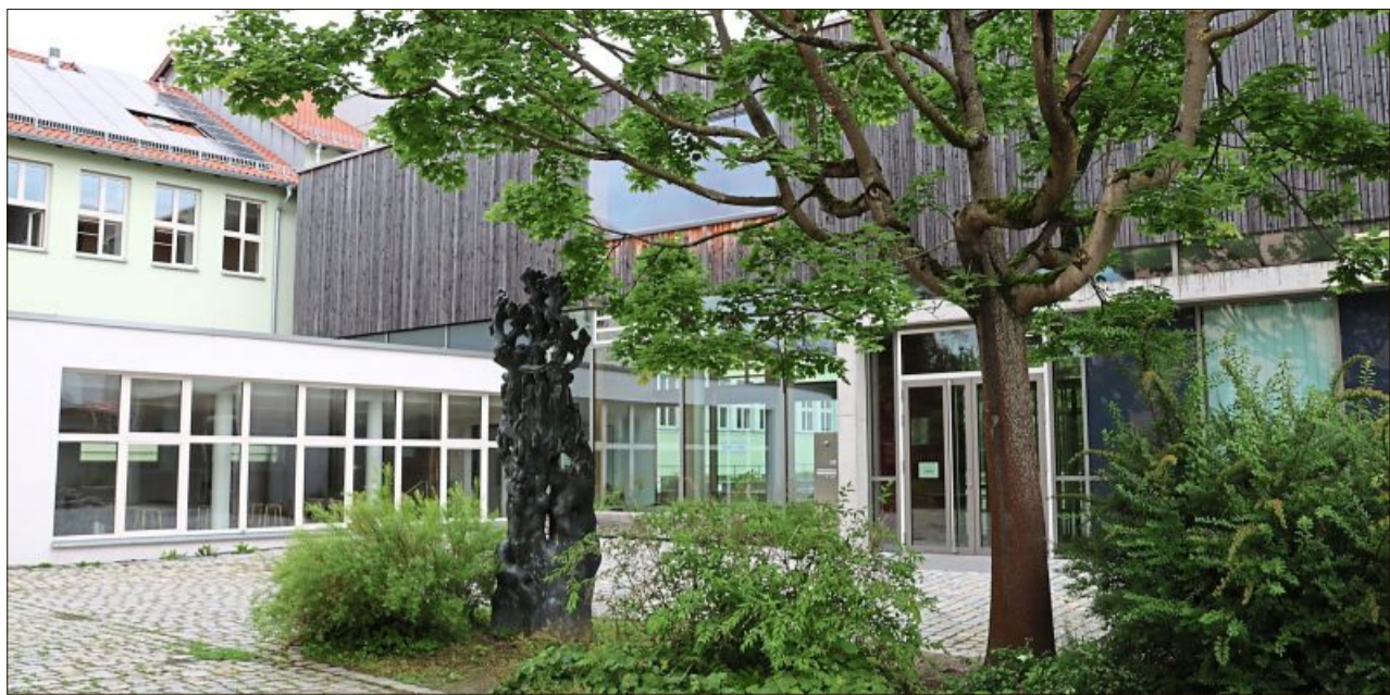
Die Generalsanierung der Further Realschule ist so gut wie abgeschlossen. Im letzten Bauabschnitt werden noch die Turnhalle und die Außenanlagen erneuert. Foto: Julia Adam
